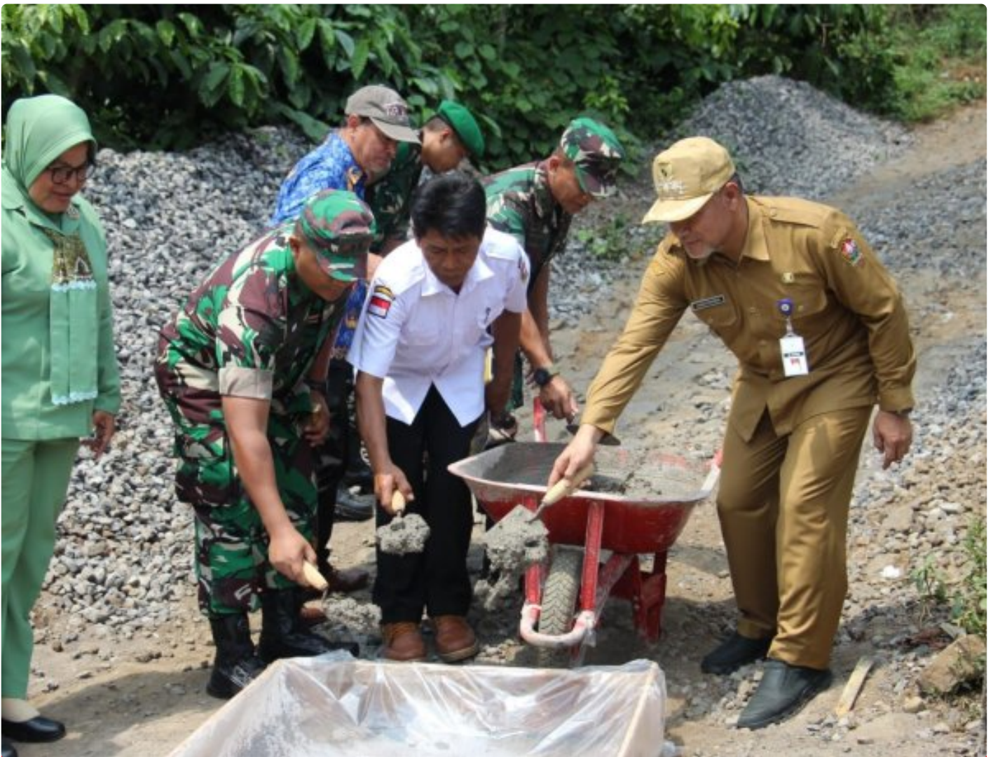
Simbolis Pengecoran Pertama Betonisasi
