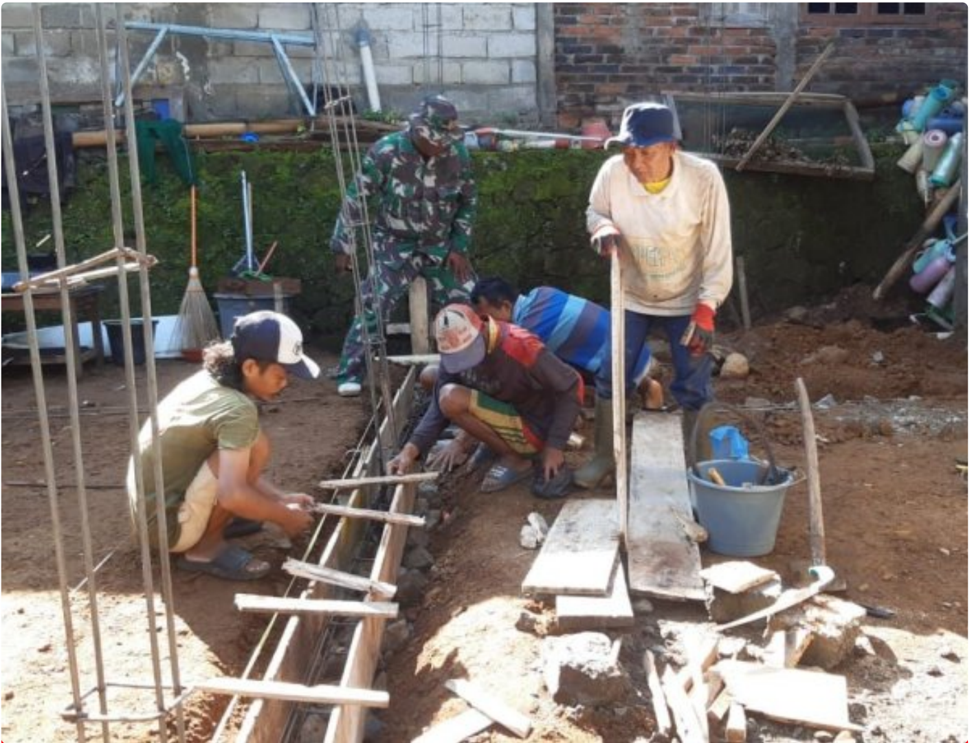
Pemasangan Bekisting Balok Sloof
